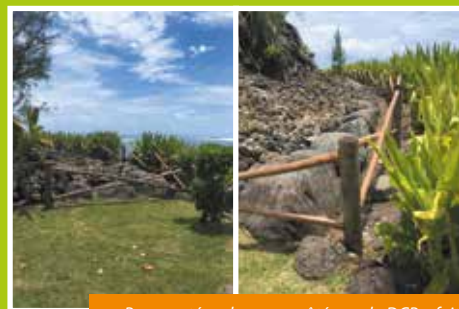
Pour protéger le marae côté mer, la DCP a fait installer une barrière végétale en bois de 'aito.
